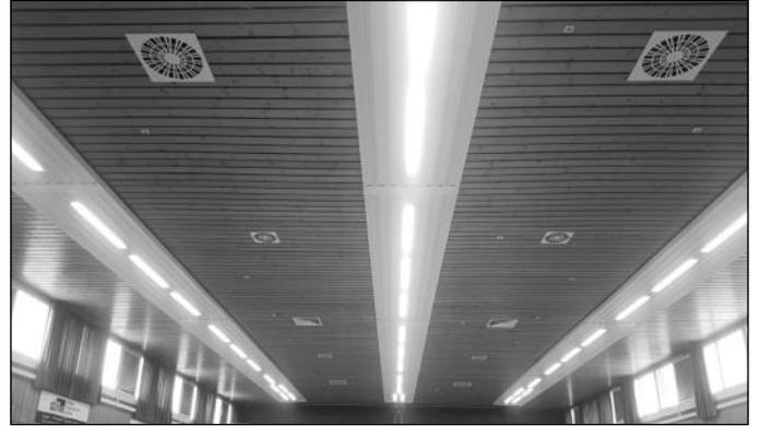
Fast übersieht man beim Anblick der Deckenstrahlheizung, dass auch eine neue LED-Beleuchtungsanlage eingebaut wurde. Diese schaltet sich automatisch mit dem Betreten der Halle ein, kann verschiedene Lichtintensitäten anbieten und hat eine ausreichende „Wettkampfreserve“ für spannende und packende Spiele.
