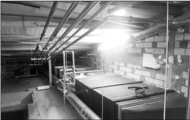
Die Steuerung der Anlage erfolgt vollautomatisch. Neben Anwesenheits-, Temperatur- und Luftfeuchtigkeitssensor, hat auch die Qualität der Luft Einfluss auf die Regelung.
