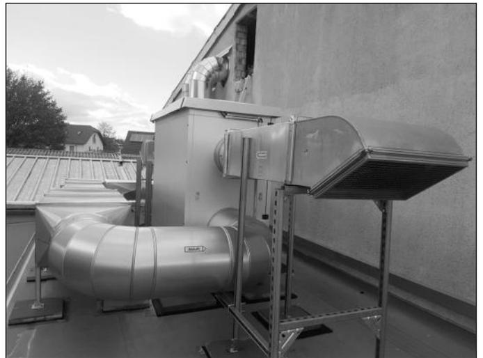
Die Zuleitung von Frischluft und Ableitung der verbrauchten Luft erfolgt unterhalb des Hallendachs. Dabei wird die in der gebrauchten Abluft vorhandene Wärme über einen Wärmetauscher zurückgewonnen und erwärmt bereits die einströmende Frischluft.
